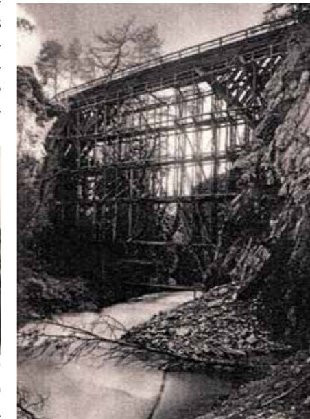
„Gerüst der Hohen Brücke (1933) errichtet von Zimmerleuten den Friedrich Erlacher, Nikolaus Rainer und Gehilfen“
