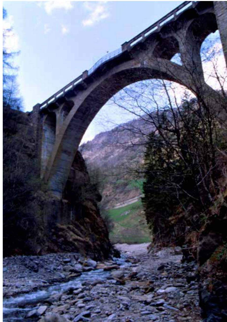
Ansicht der „Hohen Brücke“ Richtung talein. Die Brücke hat eine Spannweite von 45m und eine Höhe von 28m.
