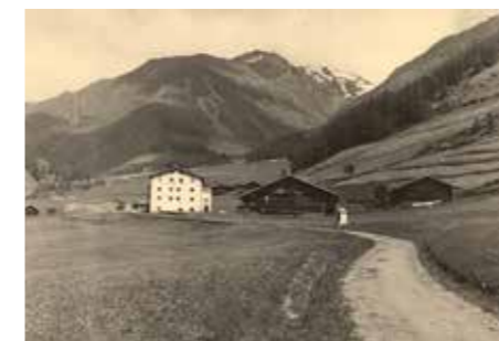
Die Straße, unterhalb der Gasthauses „Schwarzer Adler“ (Mitterhof), am Ende des 2. Weltkrieges; noch im Jahre 1944 begann man mit dem Bau der Straße nach Vernagt
