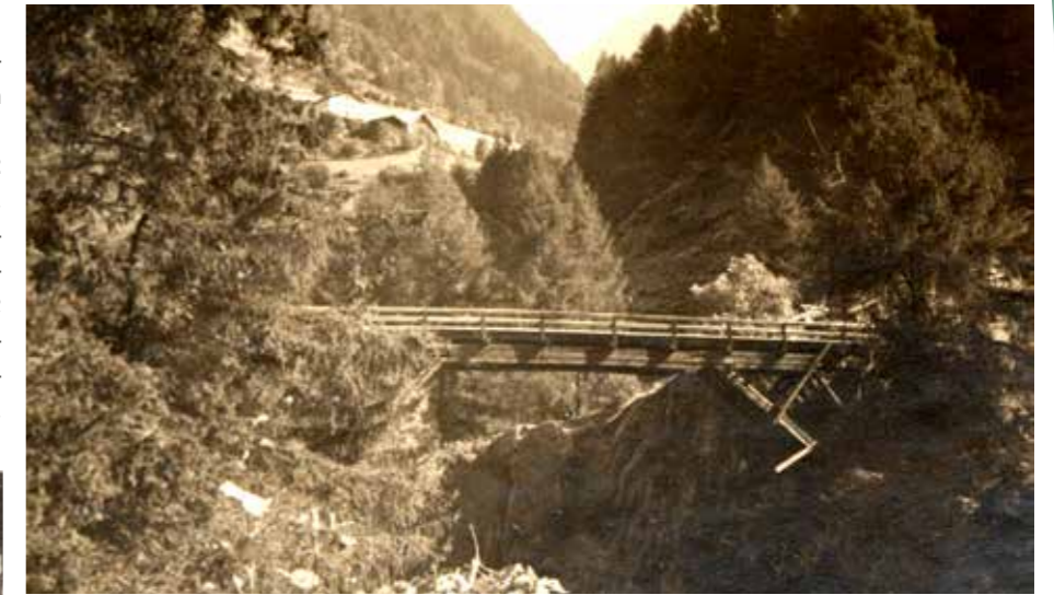
Ansicht der „Hohen Brücke“ aus Lärchenstämmen – Spannweite 39m, Höhe 28m. Sie befand sich taleinwärts unmittelbar neben der heutigen Brücke aus Beton und war während dem Bau derselben noch in Betrieb. Die Widerlager sind heute noch zu sehen
